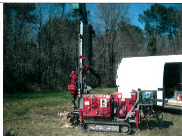
Photo 2 : Forage des piézomètres à la sondeuses
