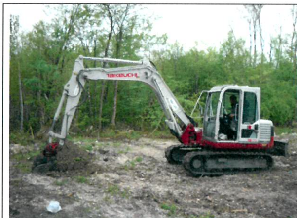
Photo 1 : Forage à la pelle hydraulique
